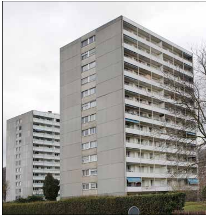
Noch ist das Ausmass der Mietzinserhöhung für die Küche- und Badsanierung an der Muttenzerstrasse Pratteln nicht bekannt.
