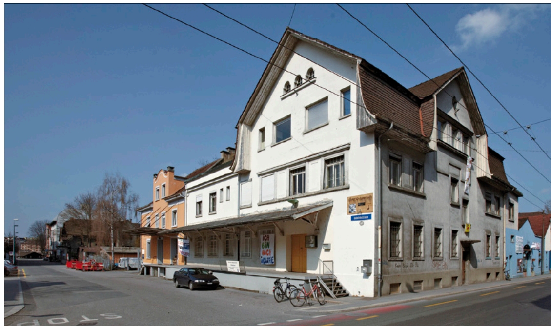
Im Industriequartier sind gemeinnützige Wohnungen, Arbeitsplätze und Ateliers geplant (Foto: Gabriel Ammon)
