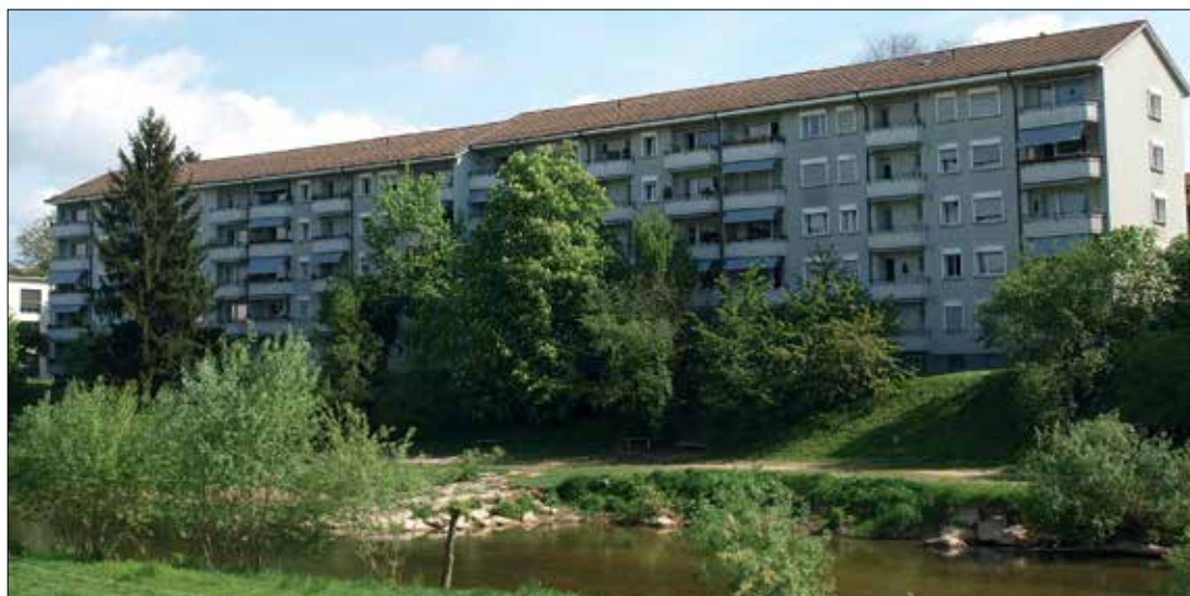
Anstelle dieser Wohnungen an der Birseckstrasse plant die Crédit Suisse ein Hochhaus.
